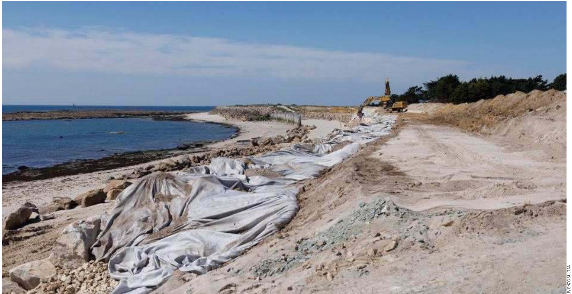
Treffragat (Finistère), jeudi. Les tractopelles œuvrent sur la plage pour renforcer en urgence les enrochements et pieux de bois mis en place en 2019, et déjà impuissants face à la houle.
